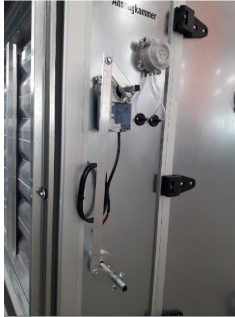
Afb. B – met gemonteerde servomotor
